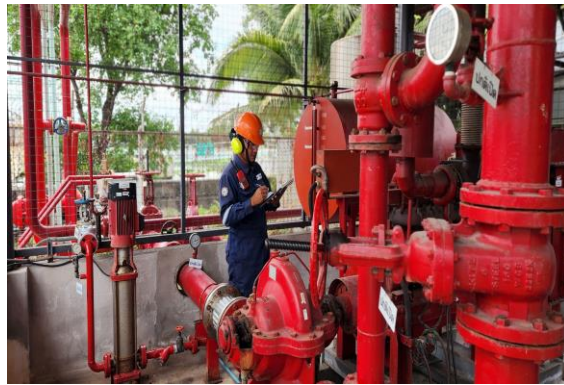
รูปที่ 3-6 ตรวจสอบอุปกรณ์ต่างๆ เครื่องสูบน้ำดับเพลิง
